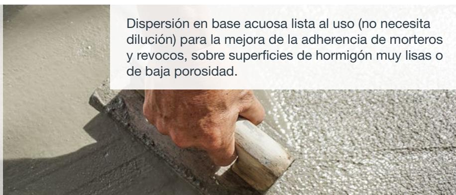
Dispersión en base acuosa lista al uso (no necesita dilución) para la mejora de la adherencia de morteros y revocos, sobre superficies de hormigón muy lisas o de baja porosidad.
